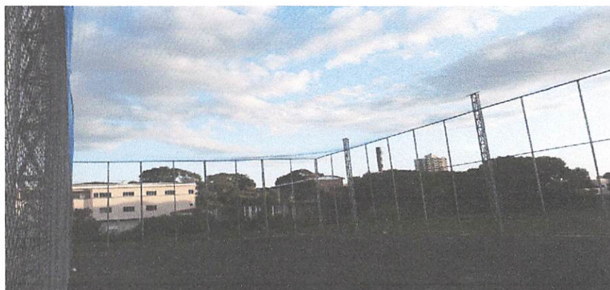
Foto 09 - -Alambrado e Redes Finalizados
